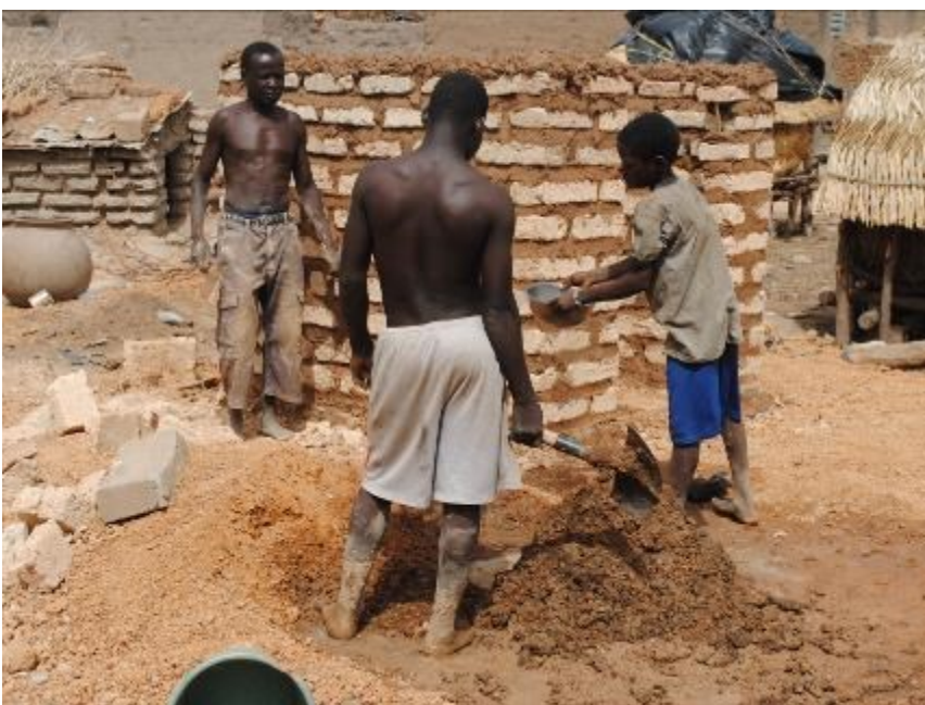
Une latrine en construction dans le village de Bazoulé.
